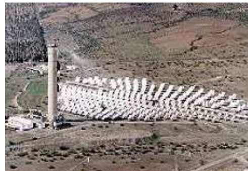
Central termosolar de Tabernas (Almería)
