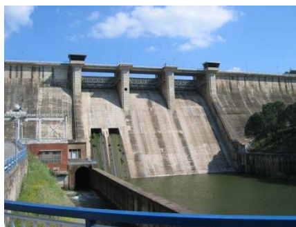
La presa de un embalse. La energía hidráulica almacenada en el agua del embalse se libera en el salto de agua de la presa para producir energía eléctrica.
